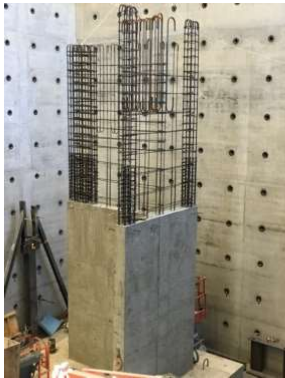
(d) Lift 2 steel cage
