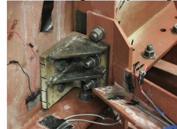
(d) Retrofit angle at bottom web-gap
